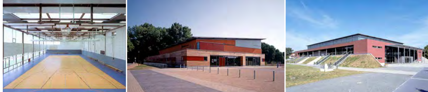
Fotos: Sporthalle Nossen, Marcel Hoefsloot | Sporthalle Schönberg, Marcel Hoefsloot | Mehrzweckhalle Weißenfels, Marcel Hoefsloot
