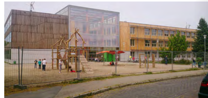
Neubau Plusenergieschule Rostock-Reutershagen
